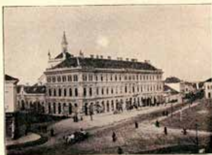
Kecskemét. — Detail de la grande place avec la rue Nagy-Károlyi-utca. (Boulevard a Gőzvel a nagy-károlyi út felé.) Detailansicht des Hauptplatzes mit der Nagy-Károlyi-Strasse.
