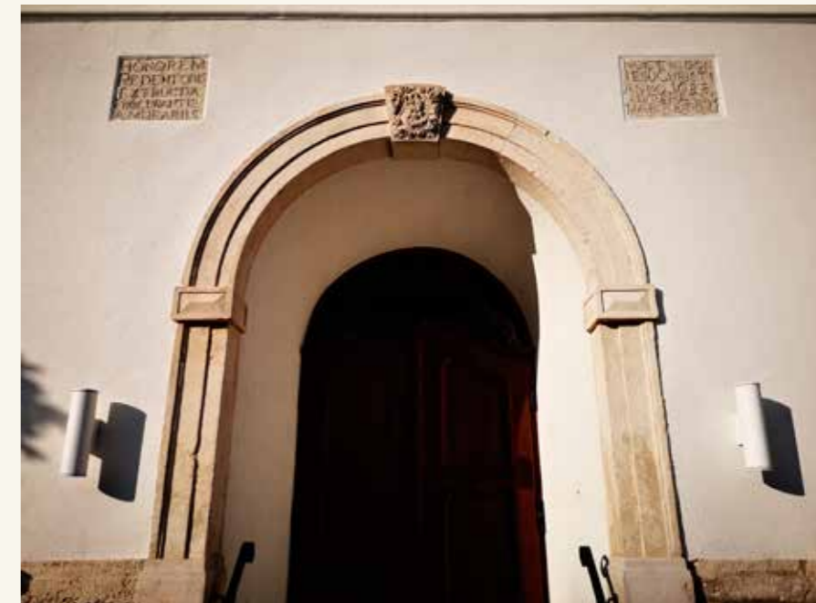
A feltehetően 1737-ben készült kapuzat kökerete az 1688-ban épült előcsarnok kapujában, felül a vakolatba karcolt eredeti építési feliratokkal (Fotó: Bezsenyi Ádám)
