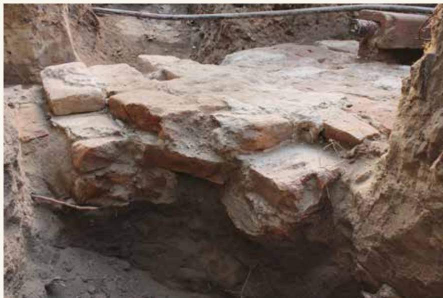
A református templom kerítésének 3 téglasornyi alapja az elbontott rész felől (Fotó: Bezsényi Ádám)
