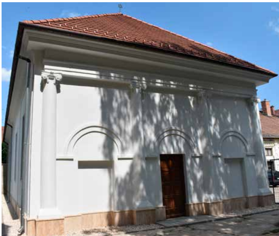
Az 1817–1818-ban épült első zsinagóga főhomlokzata 2021-ben (fotó: ifj. Gyergyádesz László)
