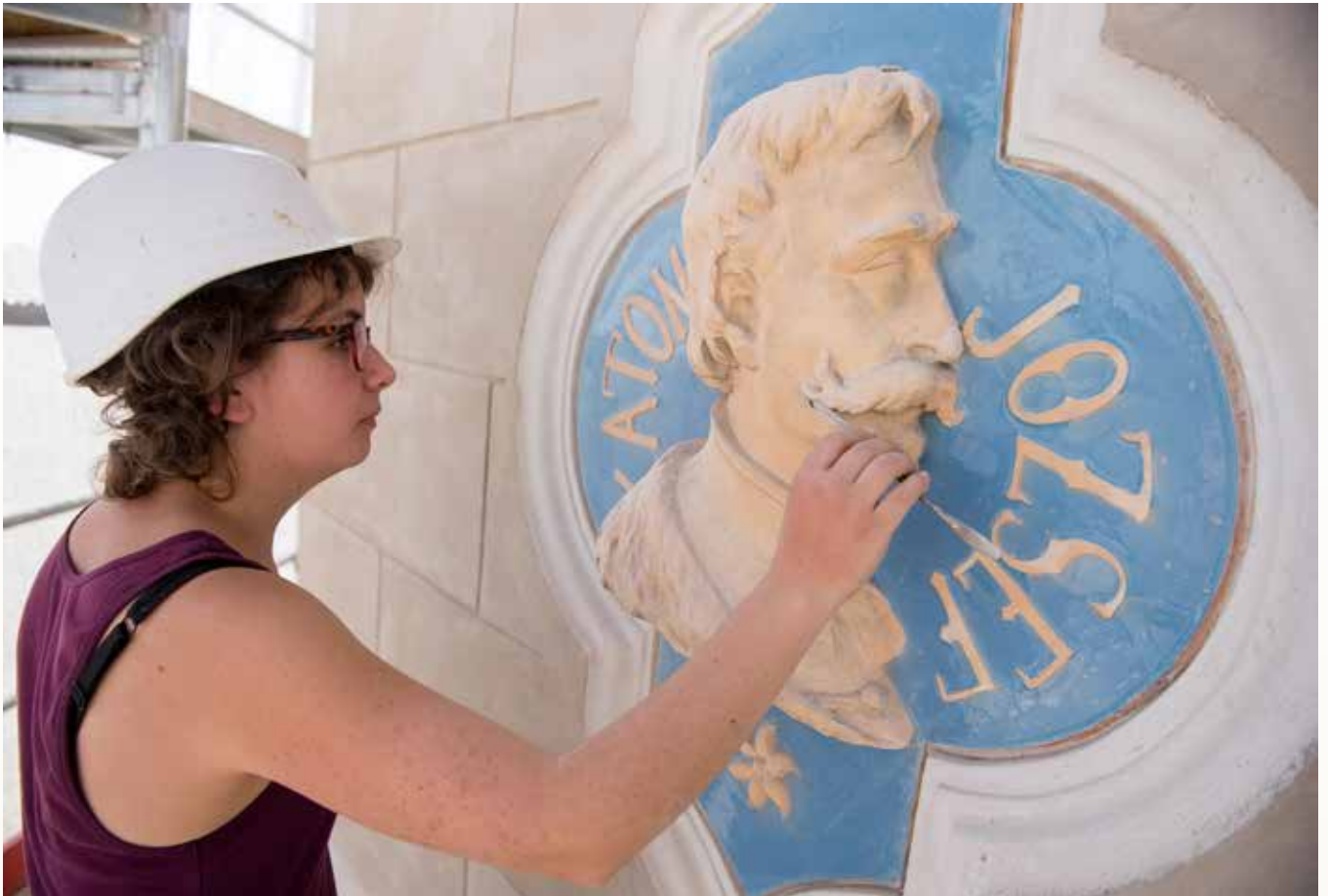
Katona József pirogránit portréjának helyszíni tisztítása 2019-ben (Fűrő Bernadett keramikus, fotó: Banczik Róbert)
