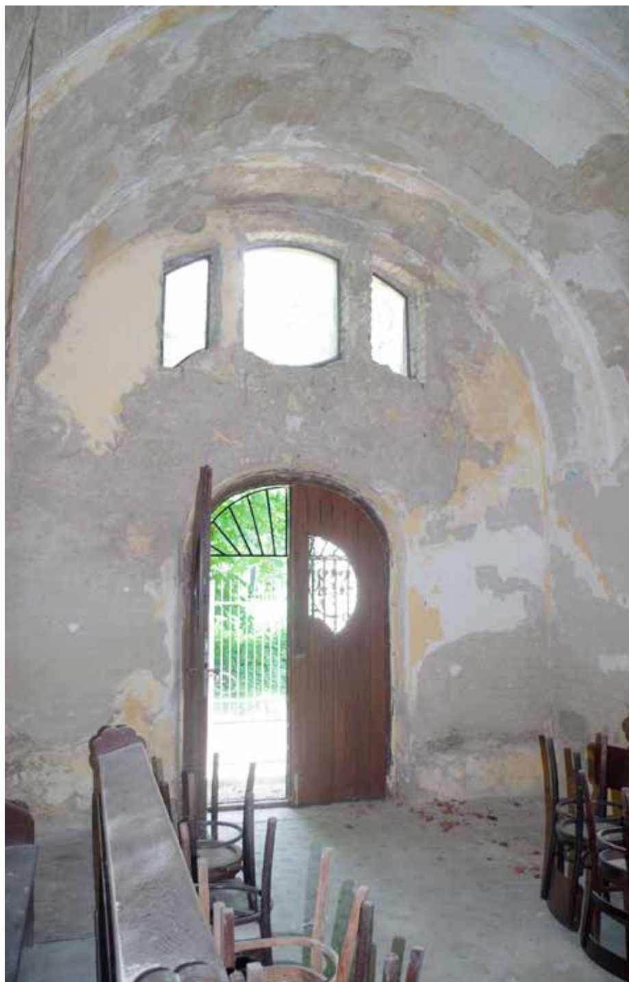
A kápolna belső tere a főbejárat felé
