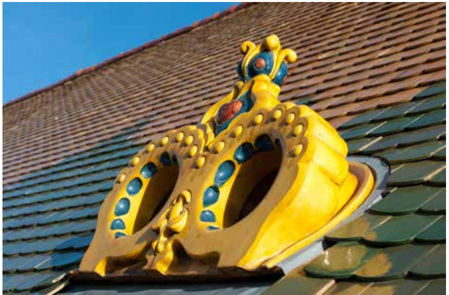
Pirogránit „galamb-kibúvó” a Cifrapalota tetőzetén
